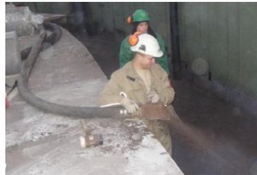
Link liefert Ihnen die verschiedensten Verfüllmaterialien für die unterschiedlichsten Anforderungen: Bunker-, Brunnen-, Graben- und Tankverfüllungen sowie Baugruben- und Arbeitsraumverfüllungen. Mit unseren Spezial-Silo-Lkw befördern wir das Material bis 150m Schlauchlänge direkt an Ihre Verwendungsstelle. Wir blasen die Verfüllstoffe „bis in den letzten Winkel“, ohne dass Sie weitere Arbeitsgeräte benötigen.
