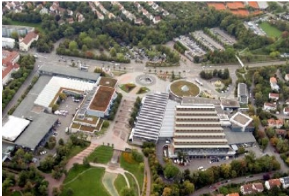
Frühere Messe Killesberg Stuttgart: Das erste Dachsubstrate-Objekt um 1985
