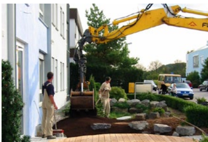
Einbau von Universalpflanzerde
