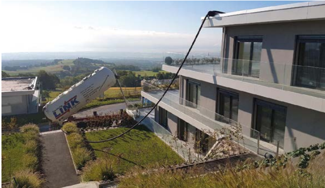
Wohnhaus Schweiz: Extensives Dachsubstrat
